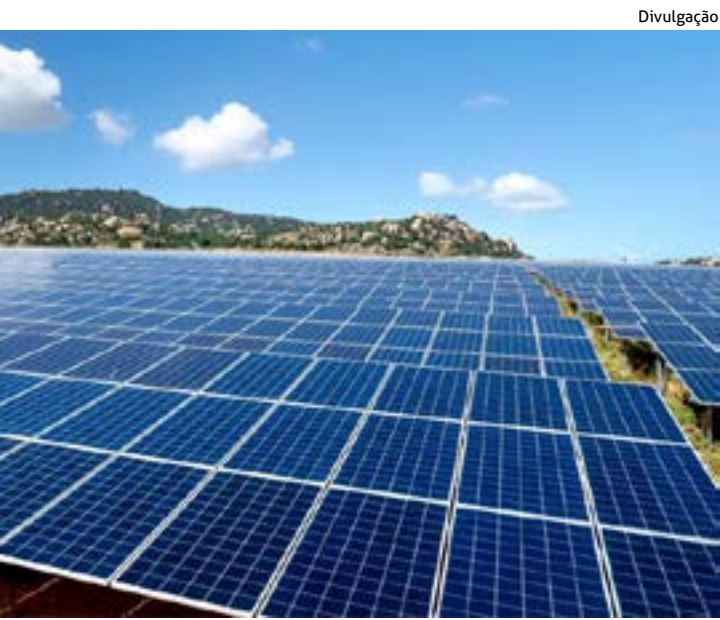
VALE DO RIO DOCE conclui obras da maior usina solar da região, impulsionando energia limpa e gerando emprego com investimento de R$ 17 milhões em Minas Gerais
