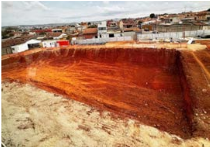
PROJETO já foi iniciado em área entre as ruas José Duarte de Paiva e Mestre Ananias e está em fase de fundação
