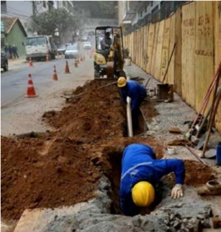
RUA PADRE FEIJÓ está recebendo novas redes de água
