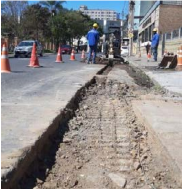
NA JUNQUEIRAS está sendo realizada a recomposição do piso
