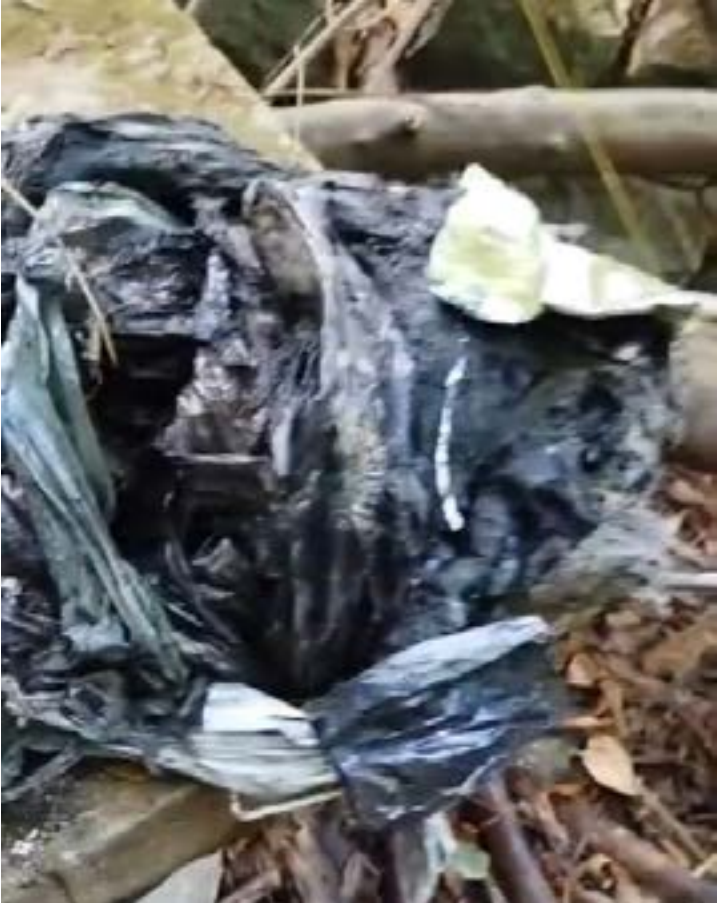
MATERIAIS retirados da rede de esgoto hoje pela manhã, na região oeste
