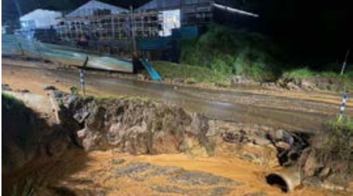
Foto: Defesa Civil de Congonhas
