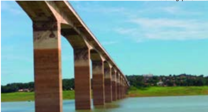
COM INVESTIMENTO de R$ 25,9 milhões, estrutura sobre o Rio Paranaíba fecha 100% neste sábado para obras de recuperação
