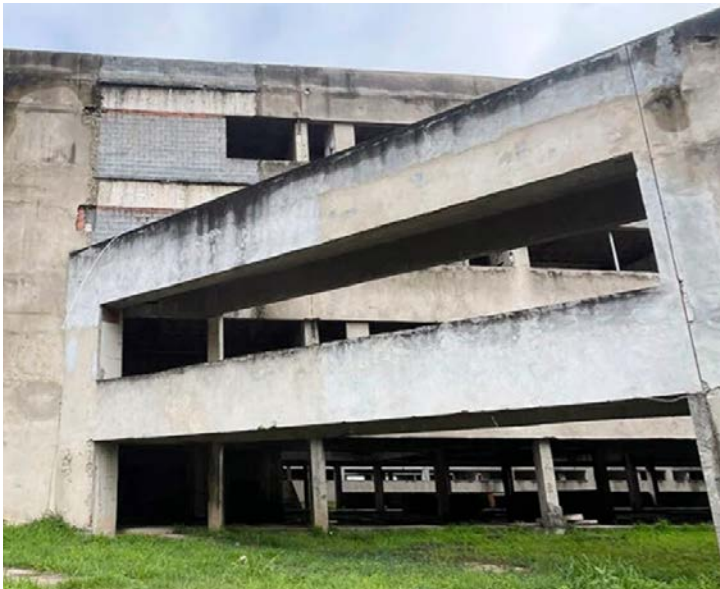
ACORDO entre Estado e Município para obras do novo Hospital de Pronto Socorro anda a passos lentos
