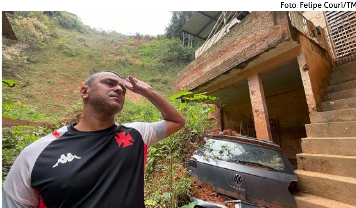
ÁREA que recebeu obra de contenção de R$ 5,3 milhões em 2024 ainda tem terra e destroços como no terreno do trabalhador Adailton Aristeu Cândido
