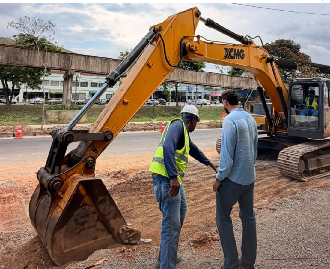
SECRETÁRIO Paulo Henrique acompanha obra na avenida João Pinheiro
